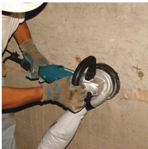
Figura: Lixamento mecânico da superfície a ser reforçada através de máquina de desbaste dotada de disco tipo vídea
