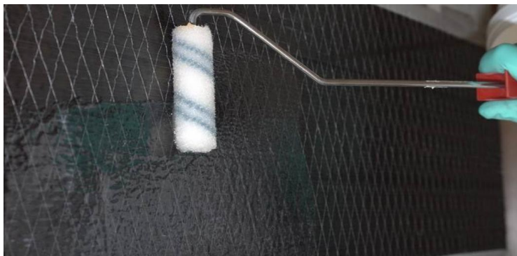
Figura 3: Aplicação da resina epóxi saturante com rolo de lã simples, MC-DUR 1200 VK
