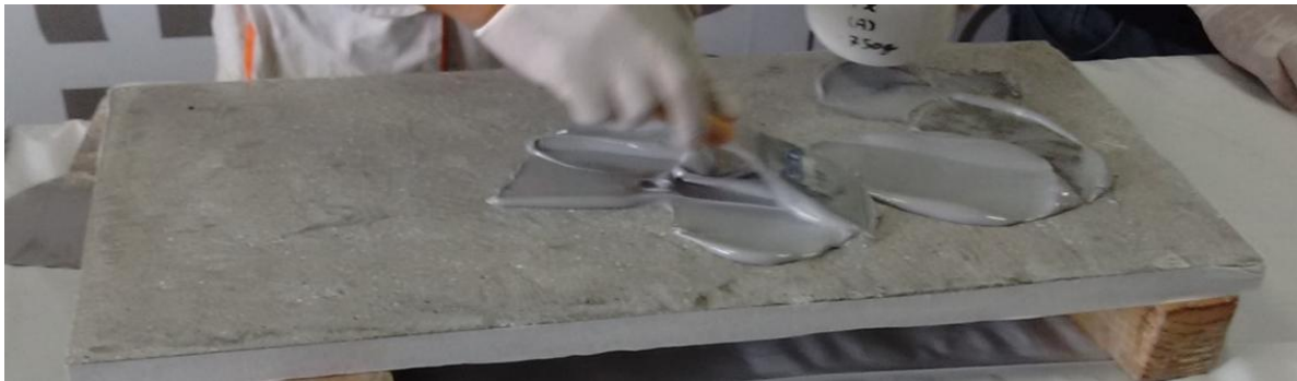
Figura: Aplicação do MC-Carbosolid 1209 TX
