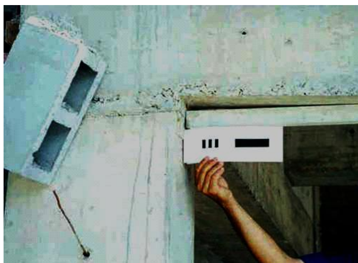
Figura: Verificação do desnível em superfície a ser reforçada
