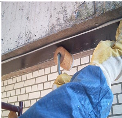
Figura: Aplicação da resina MC-Carbosolid 1300 TX na superfície da lâmina com auxílio de gabarito
