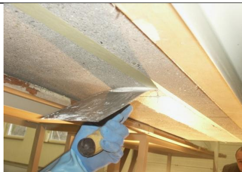
Figura: Imprimação com resina MC-Carbosolid 1300 TX
