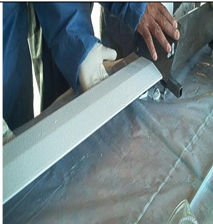
Figura: Aplicação da resina MC-Carbosolid 1300 TX na superfície da lâmina com auxílio de gabarito
