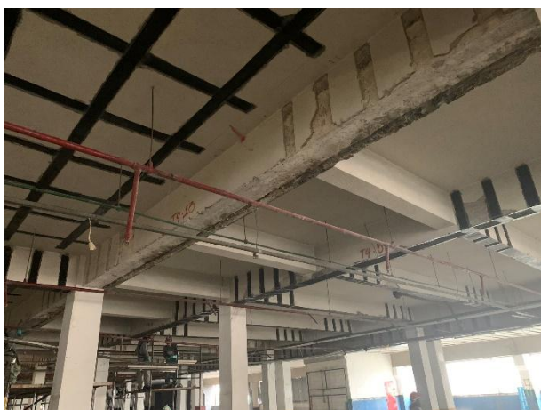
Figura: Execução de reforço de viga e laje com sistema de fibra de carbono para Esforços cortantes e flexão.
