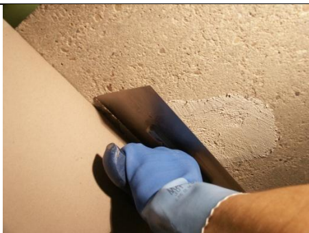
Figura: Regularização da base com MC-Carbosolid 1300 TX
