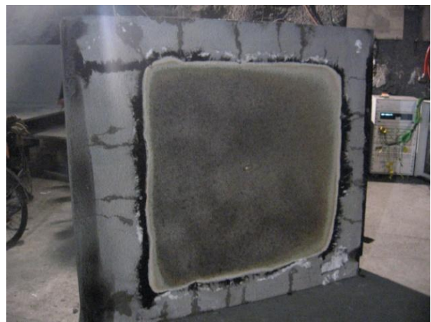
Figura: Verifica-se após 120 minutos a curva de temperatura ISO que não houve deslocamento explosivo do revestimento.
