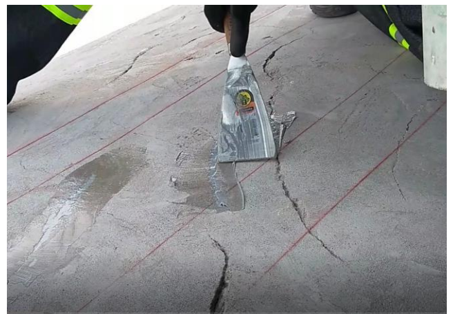
Figura: Colmatação prévia das fissuras com a resina da Linha MC-Carbosolid.
